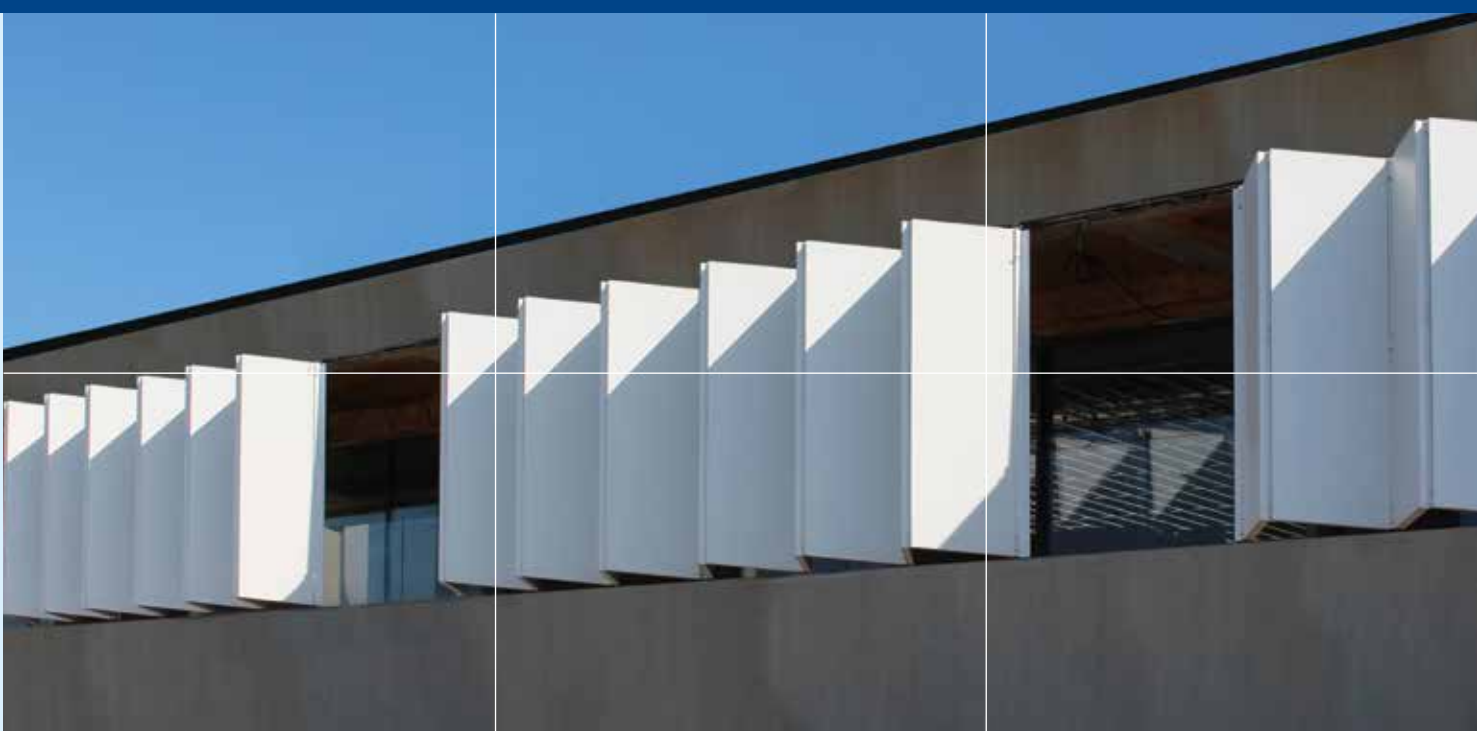
Le remplissage de surface avec de la tôle à revêtement par poudre, confère un aspect crépi lorsque le volet est fermé
